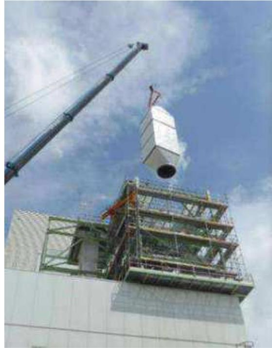
En este año 2021, se ha sustituido el silenciador de la chimenea en una de las líneas de secado de almidón lo que ha supuesto reducción del ruido significativa en la salida de la chimenea del secadero. Este foco era el principal generador de ruido y por ello de impacto acústico para el exterior. La instalación el nuevo silenciador supone una reducción neta del 96% del ruido generado, y por tanto, es inaudible desde las viviendas próximas lo que mejora sustancialmente la confortabilidad.
